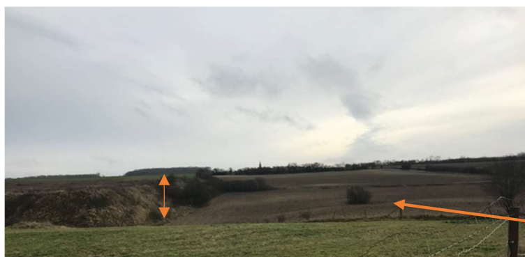
Talus hauteur de 4.5 mètres
